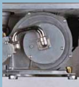
Brûleur modulant à pré-mélange constant d'air et gaz
